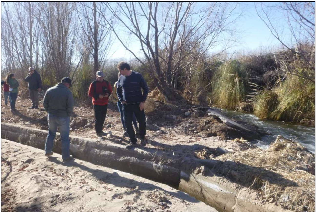
Foto 4: toma de agua del arroyo Aguanda.
